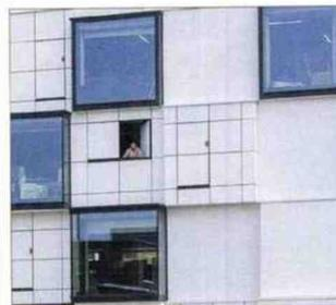
Ce double vitrage, pourvu d'une couche de contrôle solaire, améliore l'isolation thermique et le confort des espaces internes, et réduit les coûts énergétiques. Transparent, il laisse passer 60% de la lumière du jour et seulement 28% de la chaleur solaire. ■
