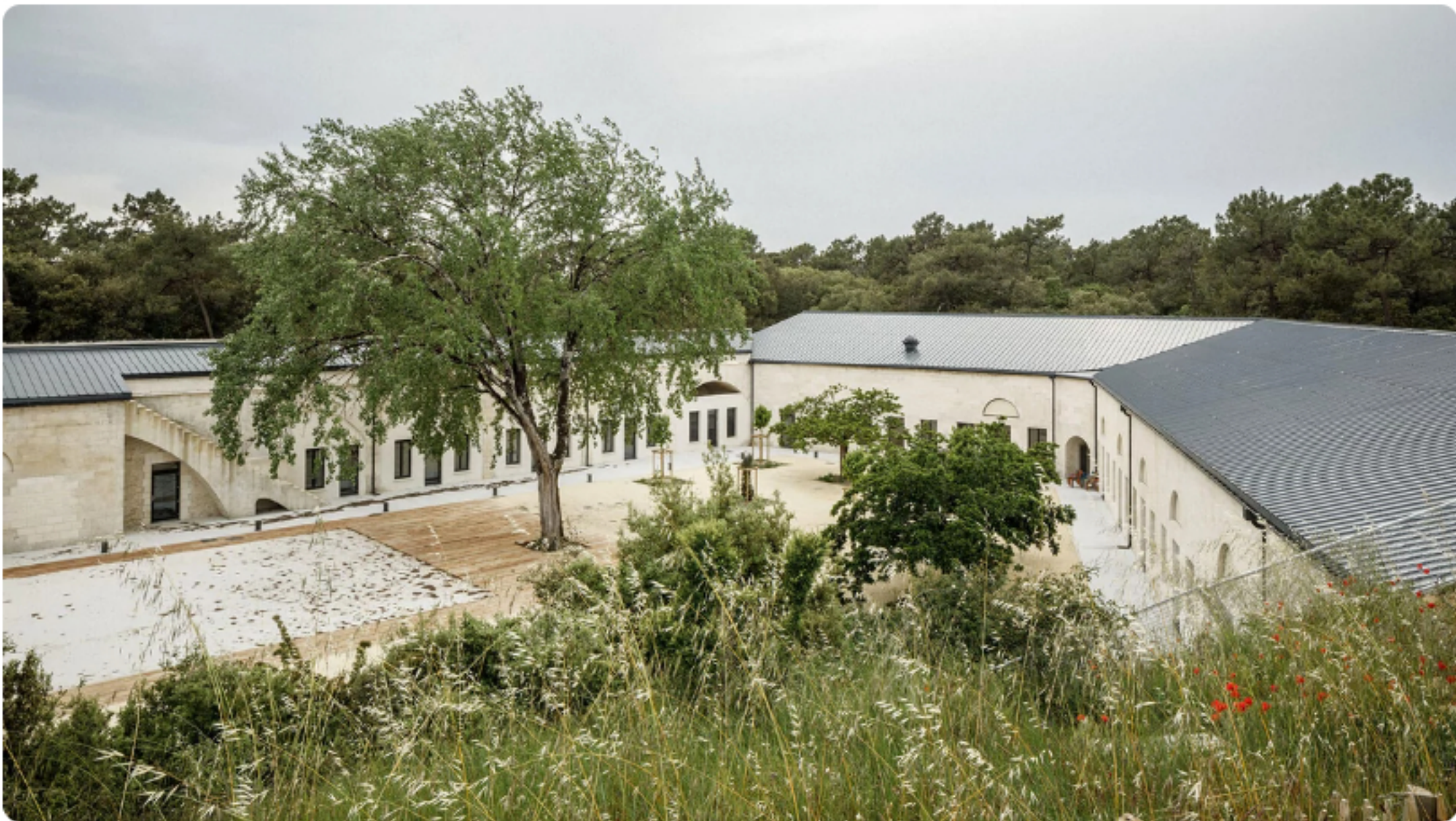
Le fort des Saumonards, remis à neuf par le cabinet d'architecture AR © 11H45
