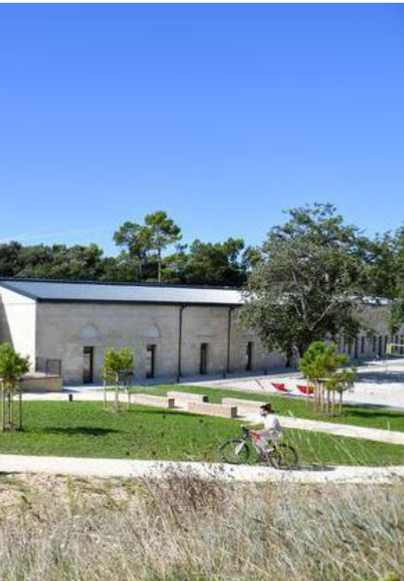
De part et d'autre de la tour centrale du fort des Saumonards, qui reste inutilisée en raison de sa fragilité, logements, postes de travail, espaces de détente et de restauration ont été aménagés. FANNY BLANCHARD
